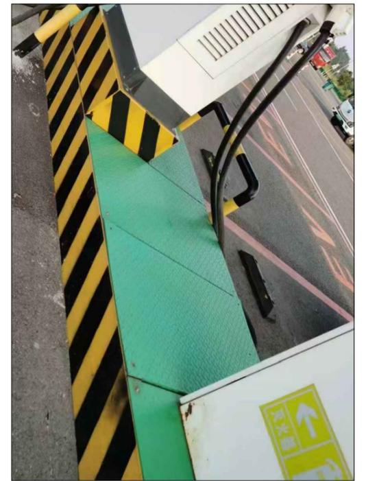
钢结构电缆槽盒刷漆参考图
